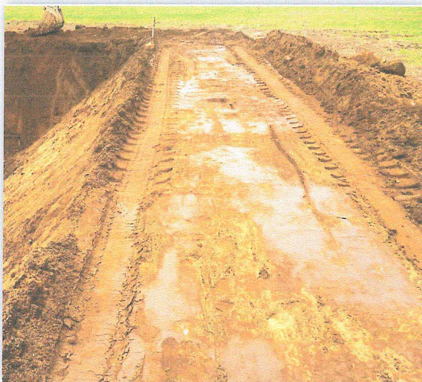
Figura A. La base es compactada al 90% del ensayo de Proctor Estándar.
