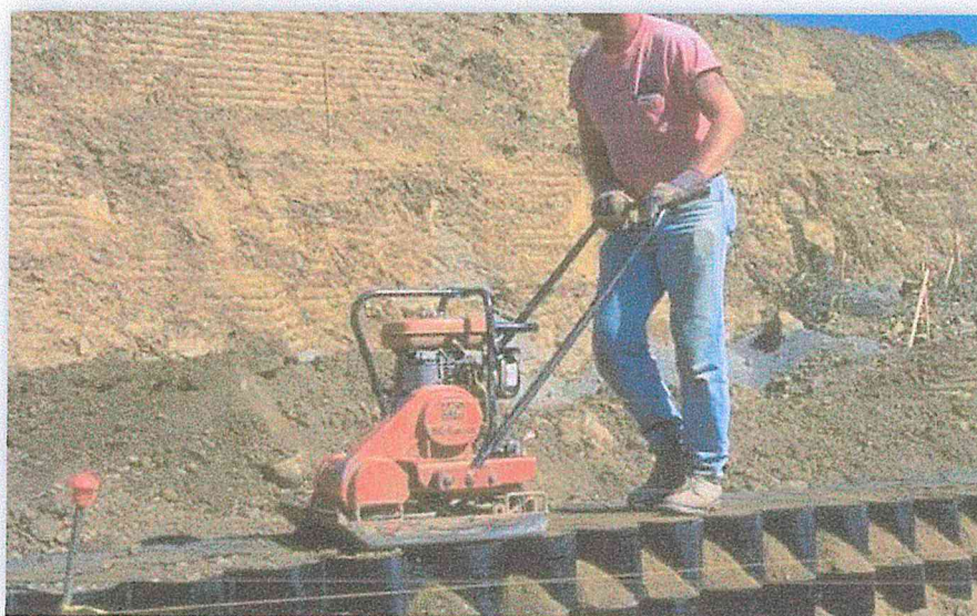
Figura D. Compactación de las capas de relleno estructural
