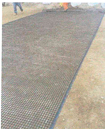
Figura D. Tendido de geomalla estructural
