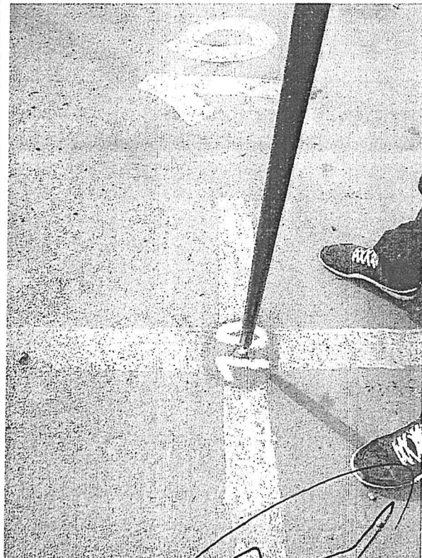
Vista fotográfica 12: Punto fotocontrol 10 monumentado sobre asfalto, en la cual se ha perforado un orificio y se ha anclado una varilla metálica sellando sus paredes con Sika Dur
