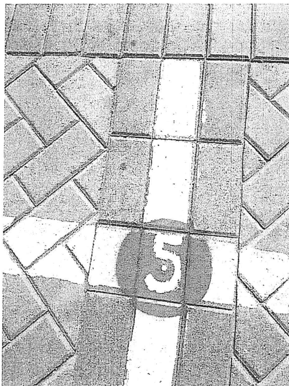
Vista fotográfica 07: Punto fotocontrol 05 monumentado sobre la vereda, en la cual se ha perforado un orificio y se ha anclado una varilla metálica sellando sus paredes con Sika Dur
