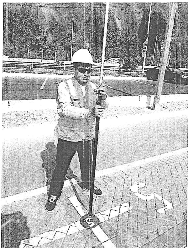
Vista fotográfica 07: Punto fotocontrol 05 monumentado sobre la vereda, en la cual se ha perforado un orificio y se ha anclado una varilla metálica sellando sus paredes con Sika Dur
