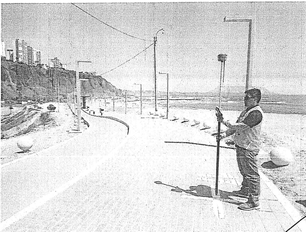
Vista fotográfica 12: Personal con Receptor Rover RTK tomando lectura del punto fotocontrol N°17, la marca fue realizada con pintura esmalte de color blanco. En total se ha marcado 20 puntos fotocontrol.
