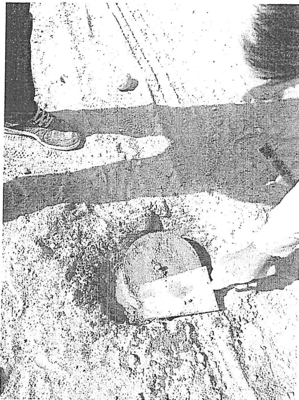
Vista fotográfica 21: Vistas sobre los trabajos de monumentación de los puntos fotocontrol
