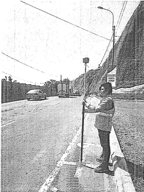
Vista fotográfica 11: Punto fotocontrol 09 monumentado sobre asfalto, en la cual se ha perforado un orificio y se ha anclado una varilla metálica sellando sus paredes con Sika Dur
