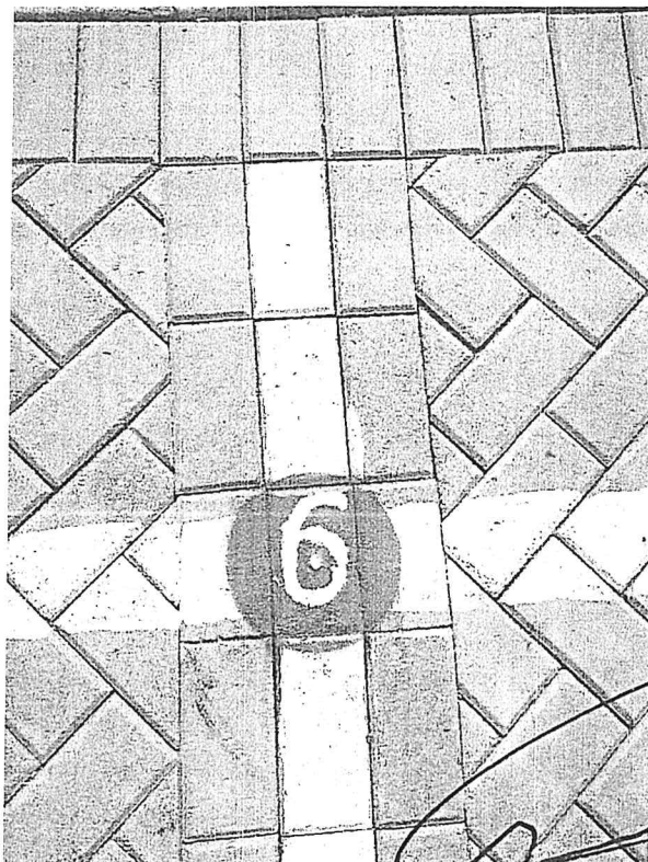
Vista fotográfica 08: Punto fotocontrol 06 monumentado sobre la vereda, en la cual se ha perforado un orificio y se ha anclado una varilla metálica sellando sus paredes con Sika Dur
