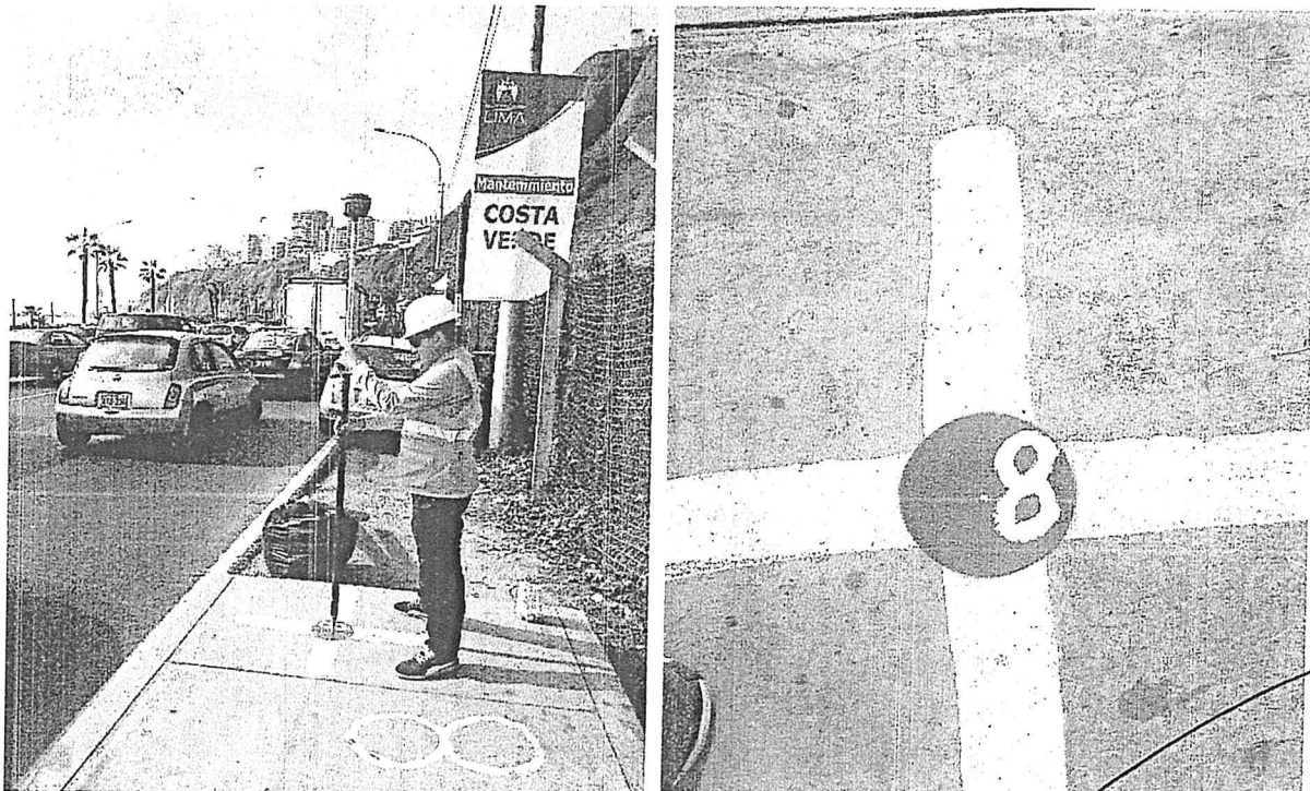
Vista fotográfica 10: Punto fotocontrol 08 monumentado sobre la vereda, en la cual se ha perforado un orificio y se ha anclado una varilla metálica sellando sus paredes con Sika Dur
