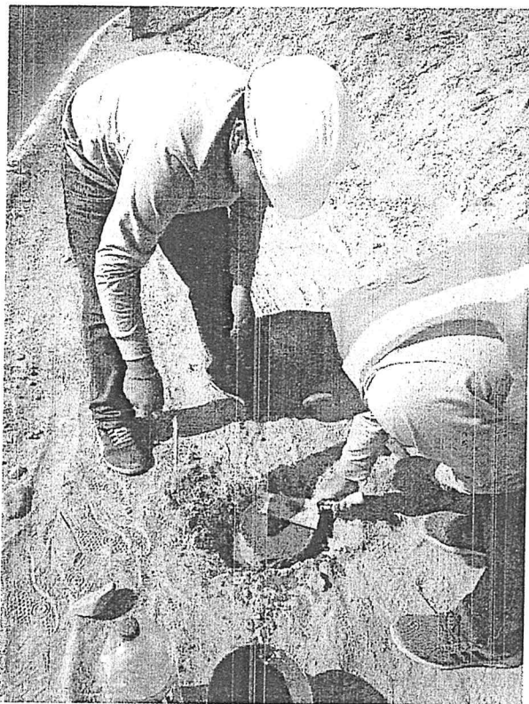
Vista fotográfica 21: Vistas sobre los trabajos de monumentación de los puntos fotocontrol
