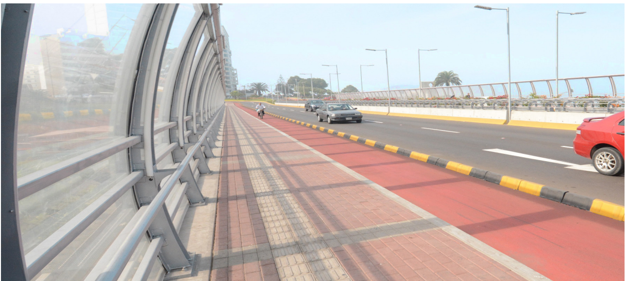
Medida de accesibilidad física: banda podotáctil en el nuevo puente Villena Rey.
