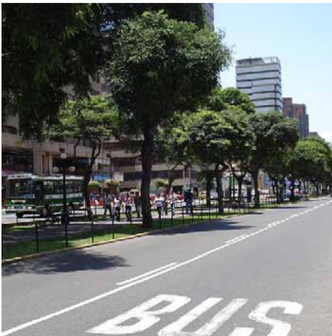
Rehabilitación de calles y avenidas.
