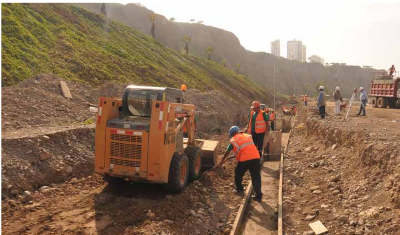
Ampliación de vía en Los Delfines, Costa Verde.
