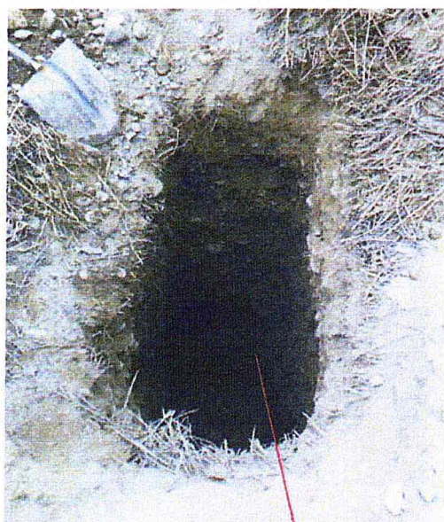
Calicata N°2: Parte Interior
