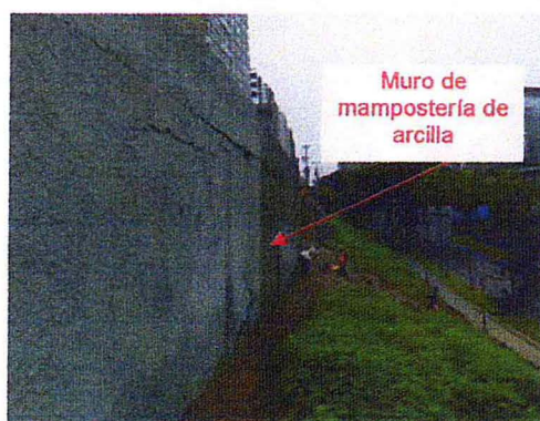
Muro de mampostería principal
