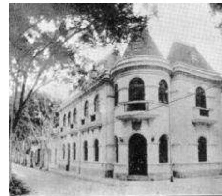
Edificio municipal.— Ampliación hacia la calle Bellavista
