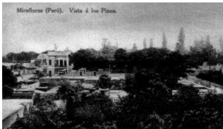
Pasaje los Pinos - Esta fue siempre una zona de pinos, tiempo atrás era un caminito angosto con piso de tierra; durante la Guerra del Pacífico esta zona quedaba entre los Reductos uno y dos.
