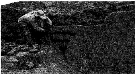
arquitectura en adobe en el Sub-sector: A5, parte Sur de la pirámide principal: elaboración de barro, fabricación de adobes para remplazar los adobes rotos, se registro gráfico y fotográfico, se aplicó capping y fraguado. Los muros trabajados son: Muro A5-08, Muro A5-12, Muro A5-14, Muro A5-15. A continuación se detalla cada una de las actividades. Finalmente en la tarea **colección de museo**, se ejecutó 26 acciones de conservación
