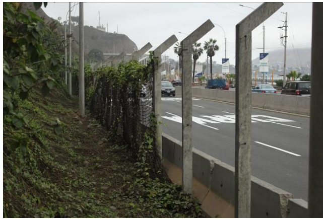
Figura 45. Vista de zona con caída de geomalla
