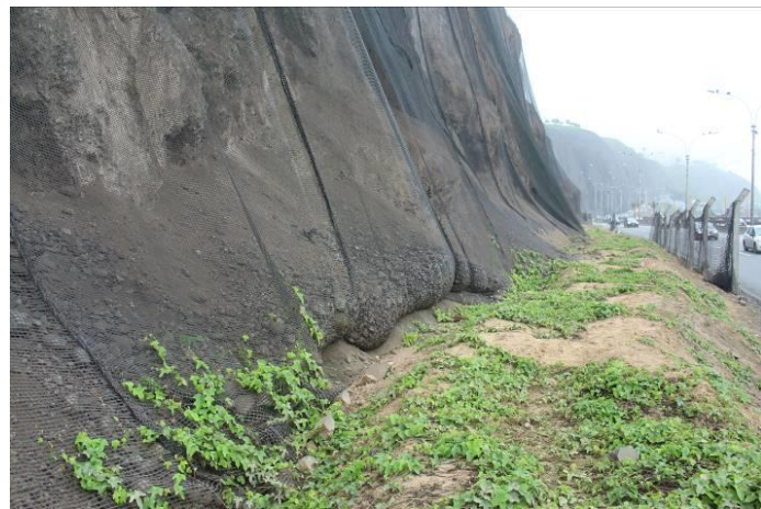
Figura 48a y 48b. En la figura de la derecha se visualiza la acumulación de rocas generando presión a las geomallas. La imagen de la izquierda corresponde a la parte alta del mismo punto y se aprecia el nivel de deterioro de la geomalla.
