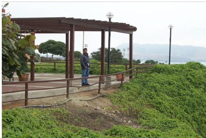
Figura 46. Vista de zona con cerco bajo
