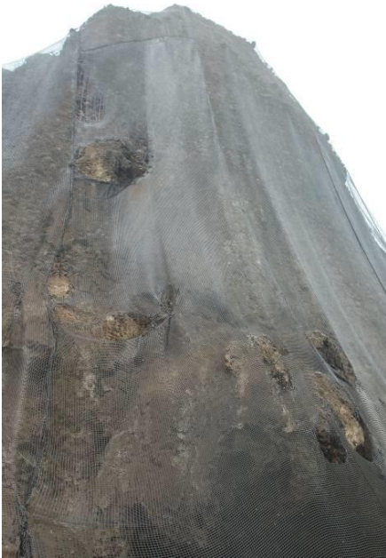
Figura 48a y 48b. En la figura de la derecha se visualiza la acumulación de rocas generando presión a las geomallas. La imagen de la izquierda corresponde a la parte alta del mismo punto y se aprecia el nivel de deterioro de la geomalla.
