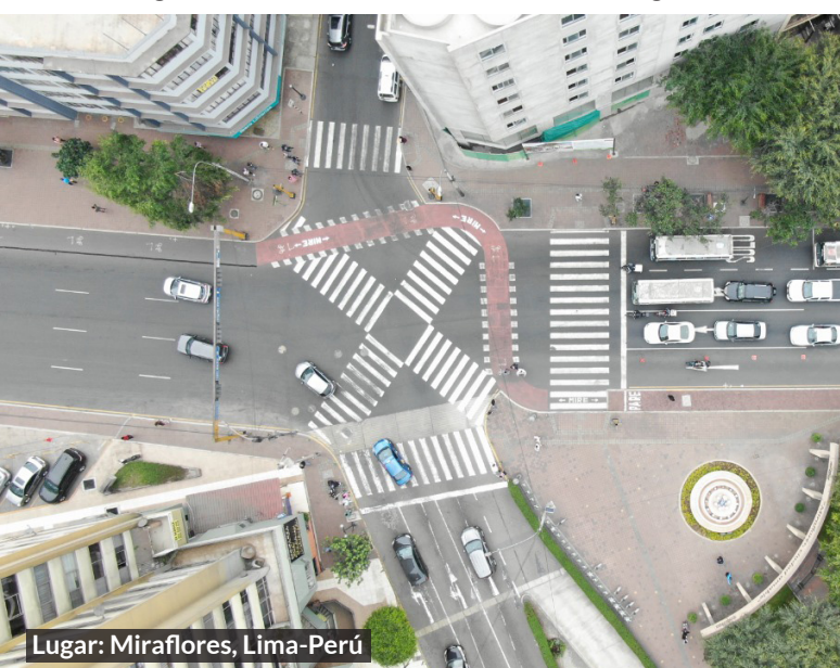
Imagen N°22: Funcionamiento de cruceros diagonales
