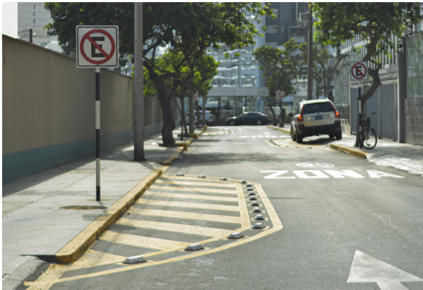
Imagen N°18: Diseño de Chicanes
