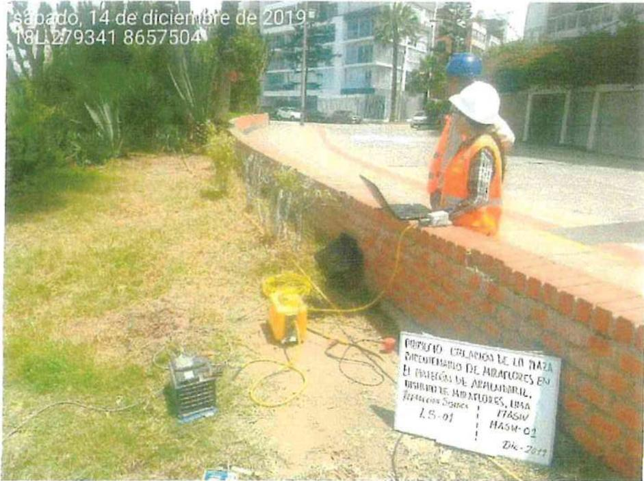
Fotografía N° 6 Desarrollo de la línea sísmica 01 y el ensayo MASW 2
