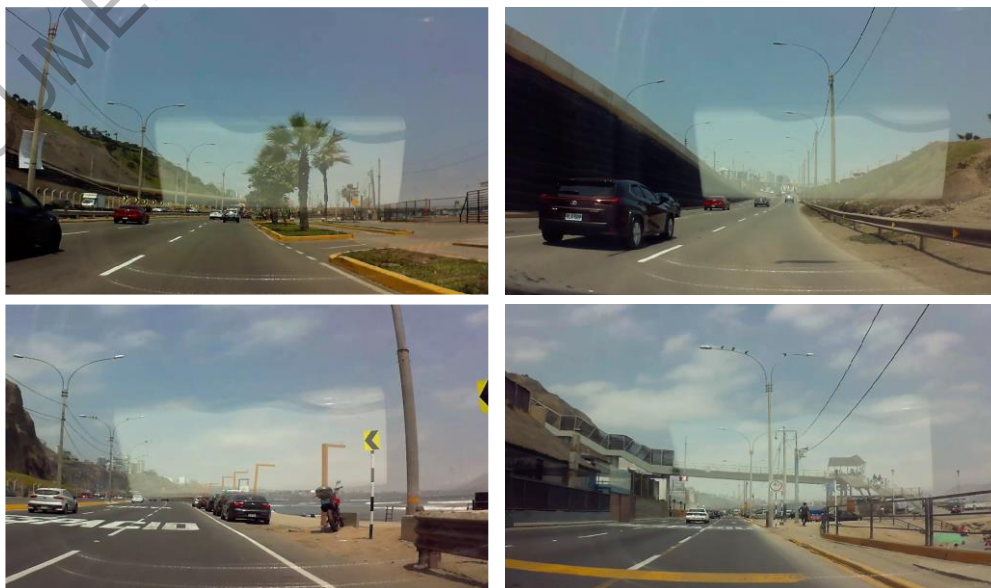
Foto N° 02/II.6.6: Discontinuidad de veredas
