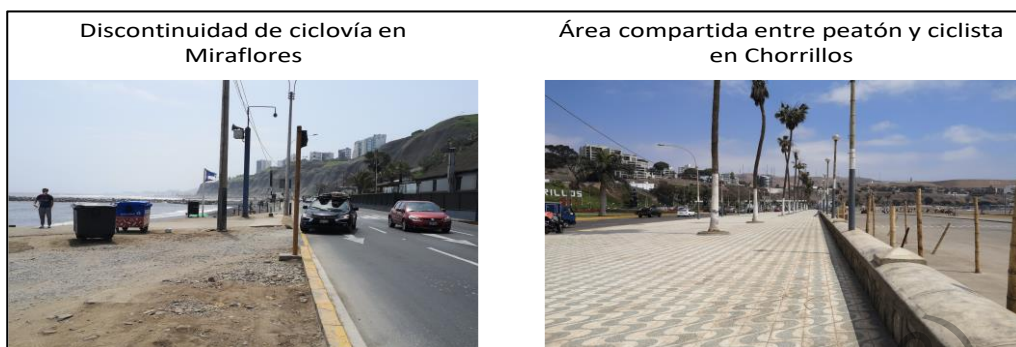
Foto N° 06/II.6.6: Estado de ciclovías en la plataforma inferior de la Costa Verde
