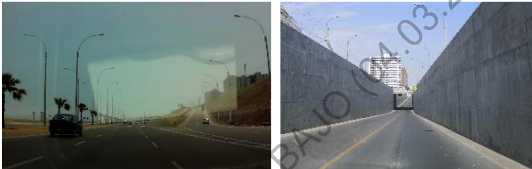
Foto N° 6/II.6.2: Acceso Bajada Rafael Escardo
