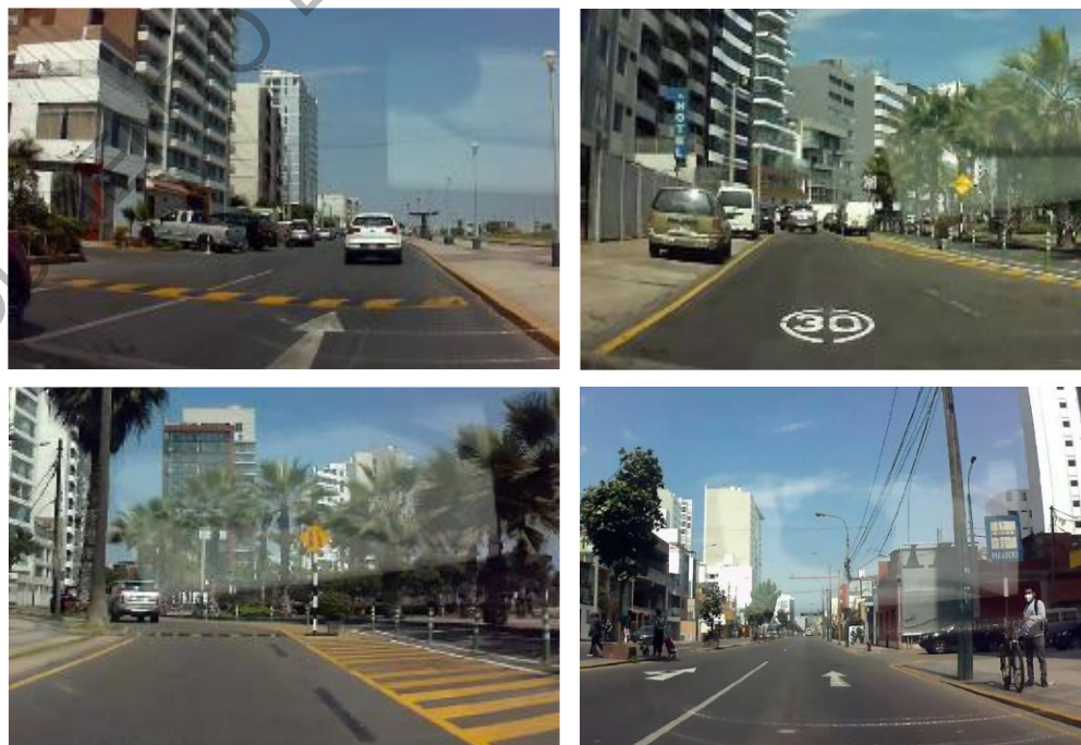
Foto N° 05/II.6.4: Señalización horizontal en el sector C
