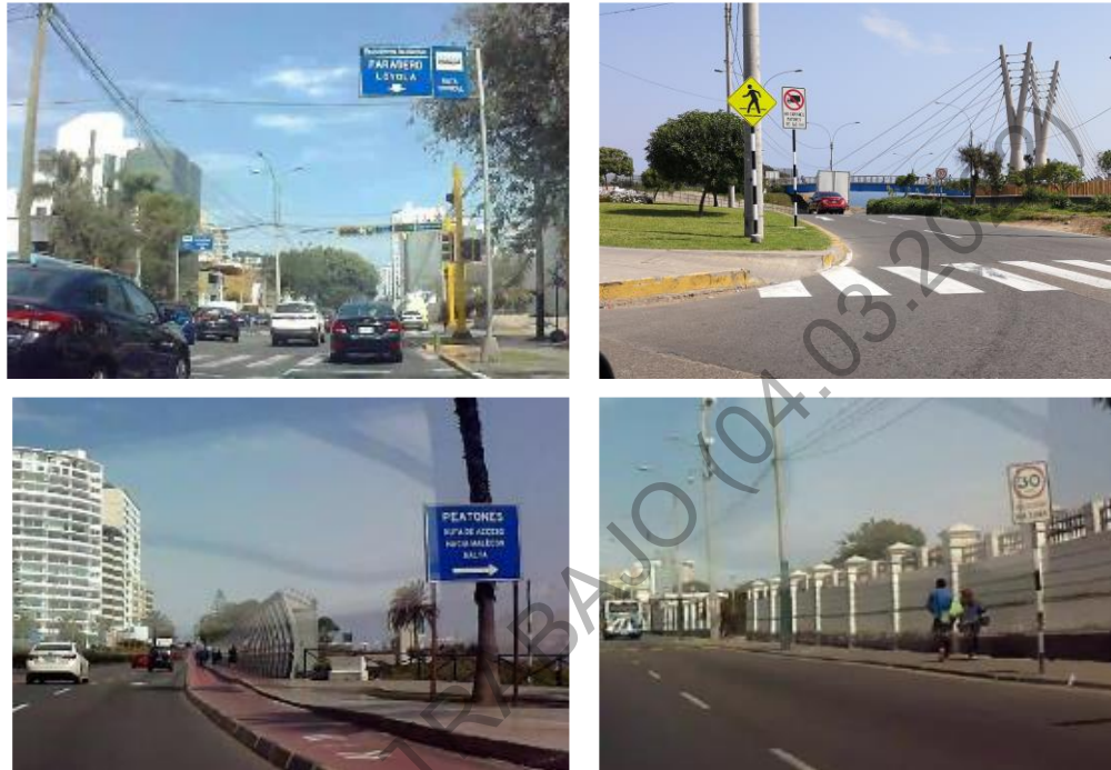
Foto N° 04/II.6.4: Señalización vertical en el sector C
