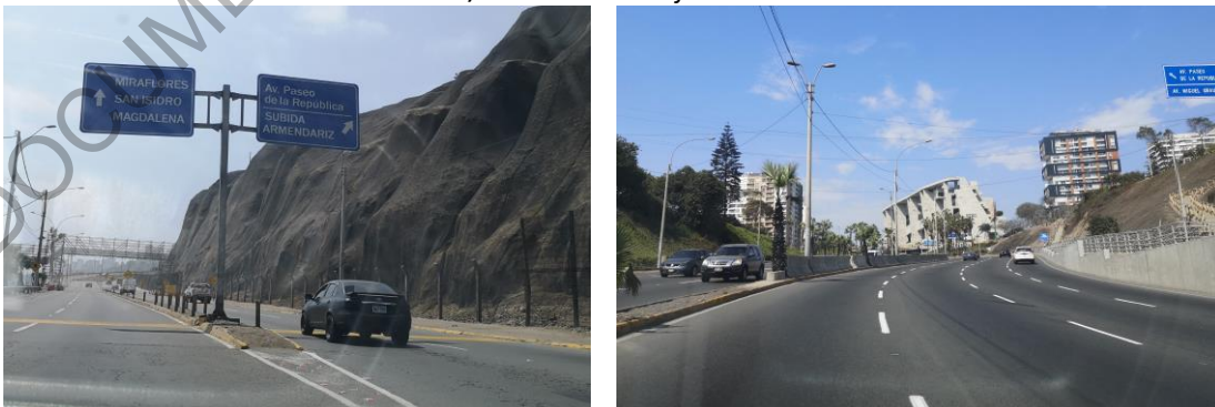
Foto N°03/II.6.2: Acceso Bajada Armendáriz
