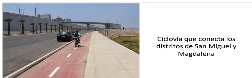
Foto N° 05/II.6.: Estado de ciclovías en la plataforma inferior de la Costa Verde
