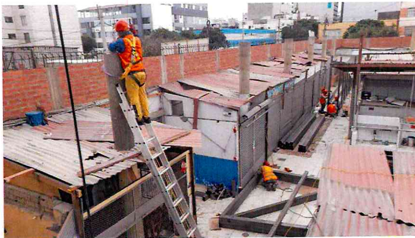
IMAGEN N.º 21. Miraflores. Mercado Municipal Santa Cruz en obras de remodelación
