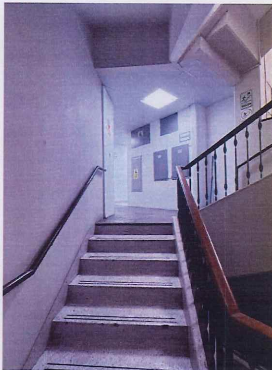
Imagen 05: Foto propia de la escalera de acceso al semisótano.
