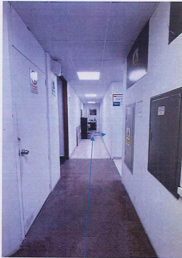
Imagen 06: Foto propia del corredor al DATA CENTER.
