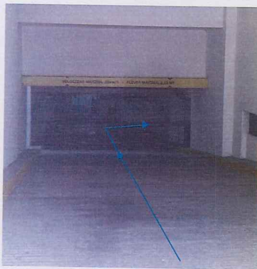
Imagen 01: Foto propia del Ingreso por Calle San Martin.
