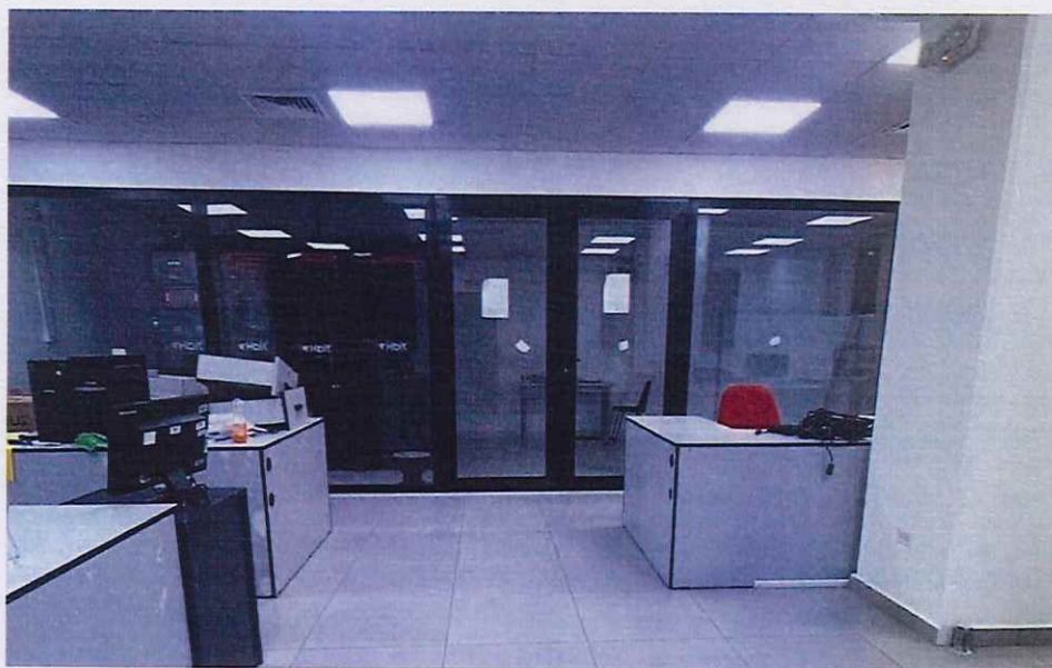
Imagen 09: Foto propia del DATA CENTER.
