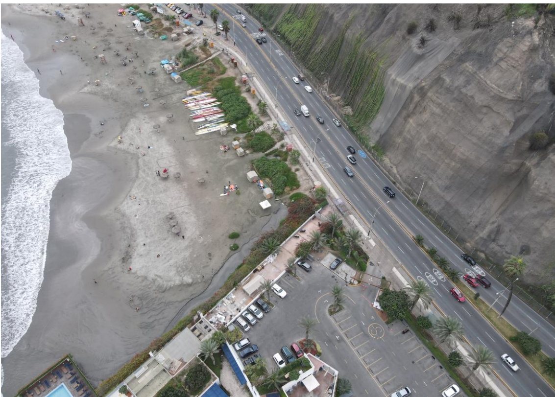
Figura 33. Los Yuyos: recorrido superficial del agua y vegetación asociada hasta su desembocadura al mar. Fotografía propia julio 2026.
