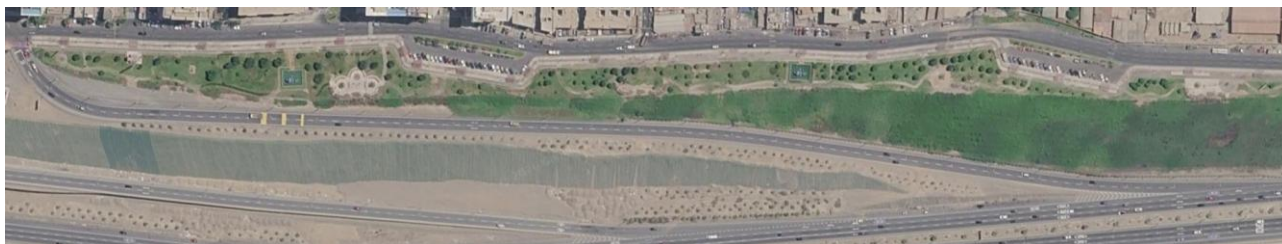
Figura 51. Malecon costanera. Fuente Google Earth
