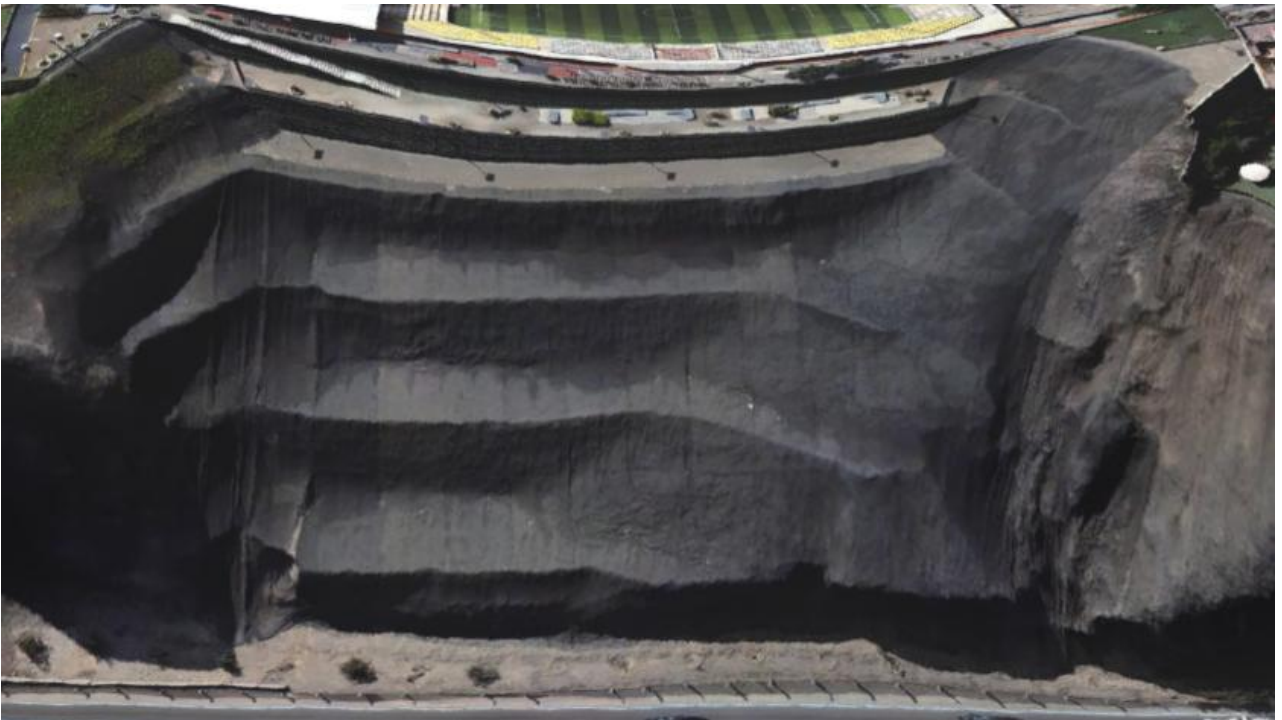
Figura 59. Trabajo de escalonamiento en talud. Fuente Google Earth
