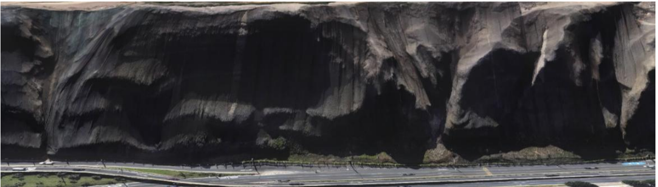
Figura 66. Trabajo de enmallado. Fuente Google Earth
