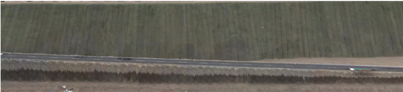
Figura 48. Trabajo de enmallado y perfilamiento del talud. Fuente Google Earth
