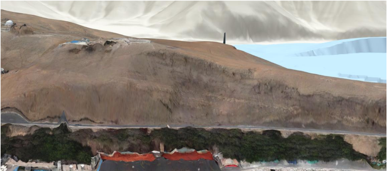
Figura 106. Talud con vegetación. Fuente Google Earth
