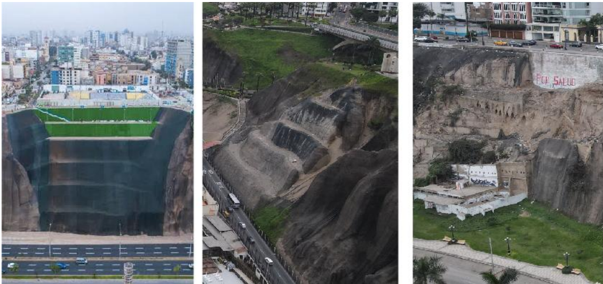
Figura 42. Intervenciones en el talud: Escalonamientos. Fotografía propia.
