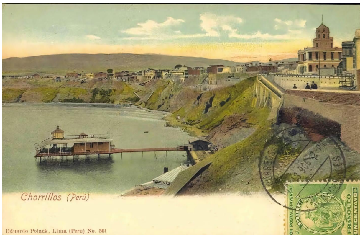
Figura 9. Paisaje histórico del balneario de Chorrillos: infraestructura recreativa, acceso al litoral y relación entre borde urbano, acantilado y mar.
