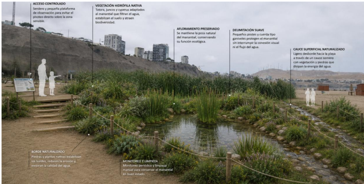
Figura 13. Manantial Sombrillas: restauración del parche húmedo y manejo naturalizado del cauce superficial. Elaboración: Equipo técnico
