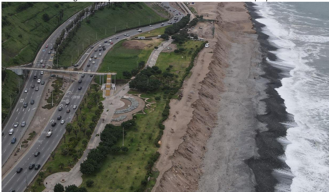
Imagen 28 Deposito de material sobre el ecosistema de playa
