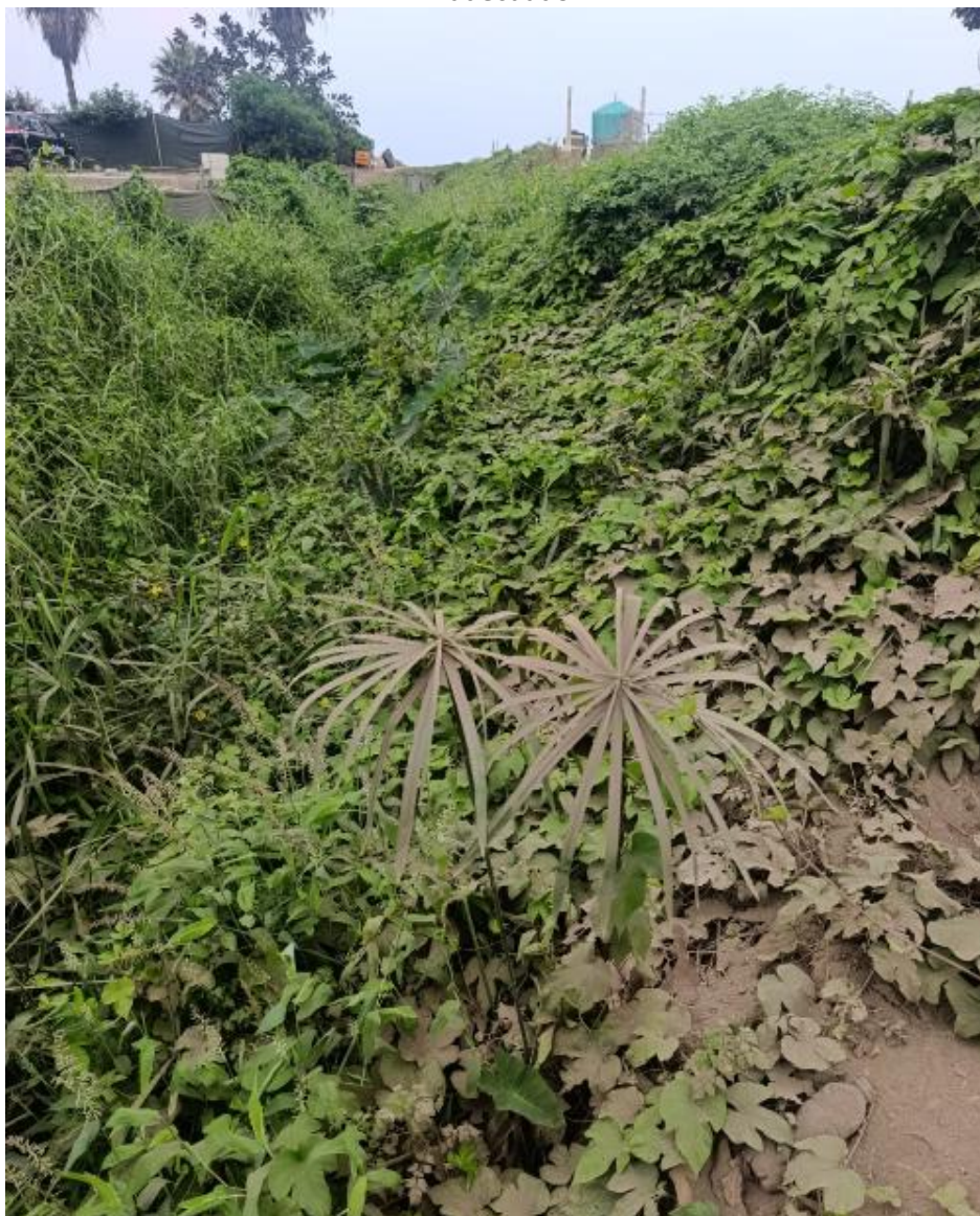
Imagen 39: Material particulado en la vegetación producto de transporte de rellenos inadecuado
