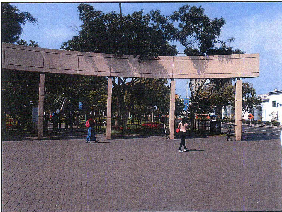
Foto N°2; Ingreso al parque 07 Junio por Ovalo de Miraflores, portico de concreto
