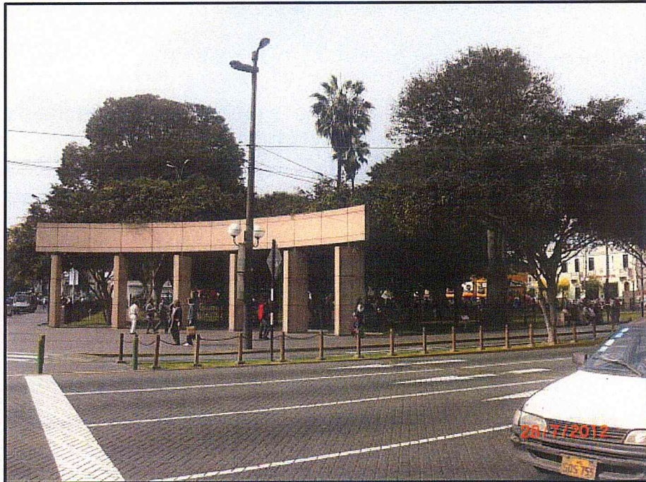
Iluminación Actual / Fuente: Elaboración Propia
