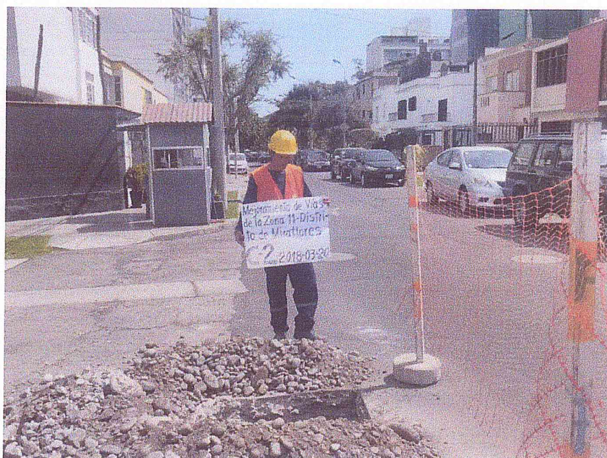
FOTOGRAFÍA N° 4: Ubicación de la calicata C-2 hacia el noreste del área de estudio, en la intersección de la calle Enrique del Campo y la calle General Vargas Machuca.
