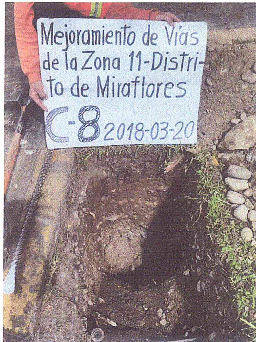
FOTOGRAFÍA N° 23: Perfil del suelo en la calicata C-8.
