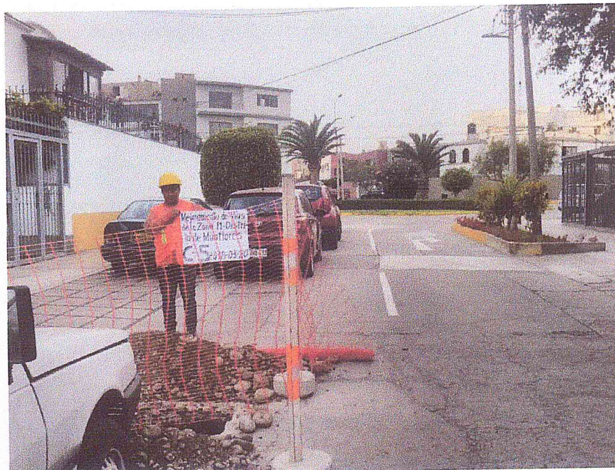
FOTOGRAFÍA N° 13: Ubicación de la calicata C-5 hacia la parte central del área de estudio, en la intersección de la calle Martín Dulanto y la calle Bartolomé Trujillo.
