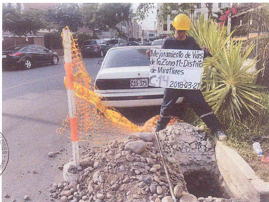
FOTOGRAFÍA N° 40: Ubicación de la calicata C-14 hacia el norte del área de estudio, en la calle Iribarren, cerca de su intersección con la calle General Vargas Machuca.
