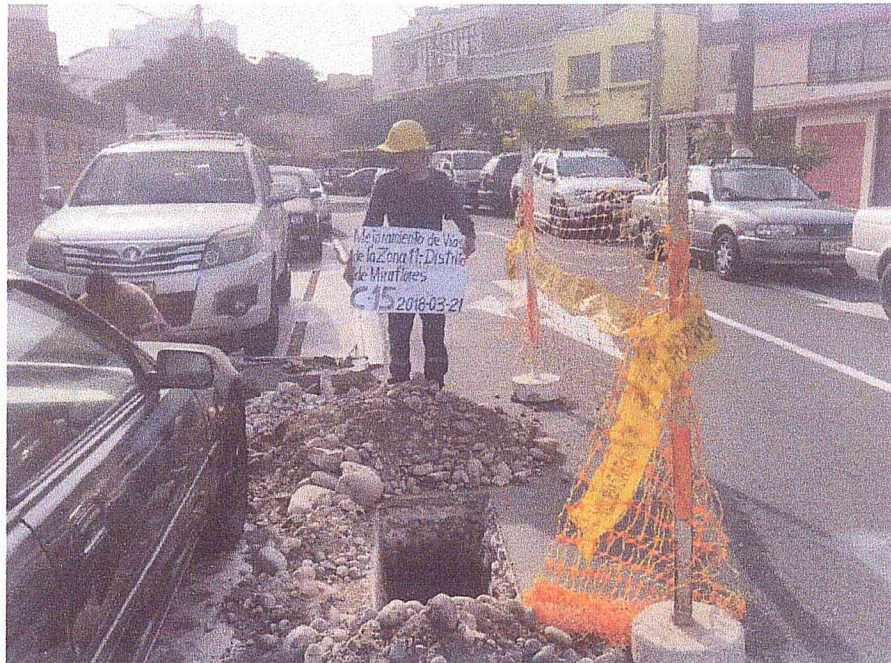
FOTOGRAFÍA N° 43: Ubicación de la calicata C-15 hacia el norte del área de estudio, en la calle General Vargas Machuca, cerca de su intersección con la calle Irribarren.
