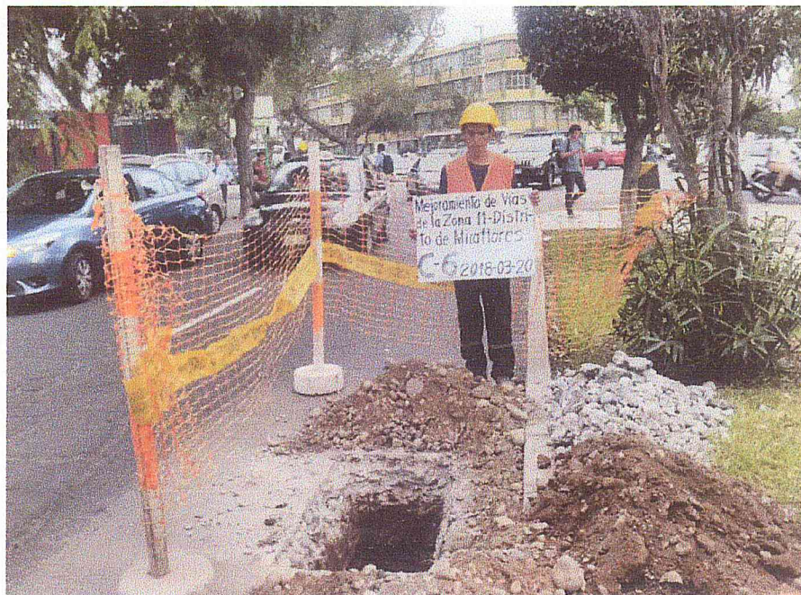
FOTOGRAFÍA N° 16: Ubicación de la calicata C-6 hacia el oeste del área de estudio, en la calle Ramón Ribeyro, cerca de su intersección con la Av. Alfredo Benavides.
