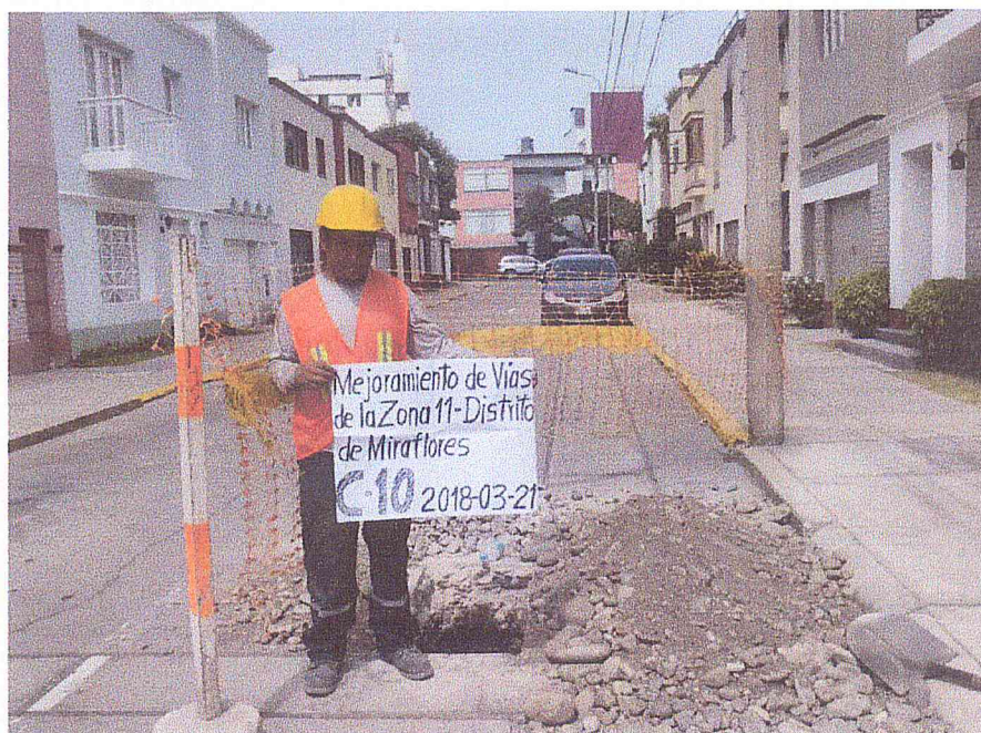
FOTOGRAFÍA N° 28: Ubicación de la calicata C-10 hacia el este del área de estudio, en la calle San Antonio, cerca de su intersección con la calle Francisco de Paula Ugarriza.
