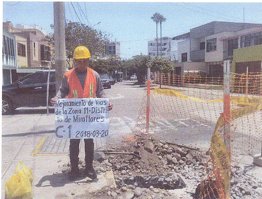
FOTOGRAFÍA N° 1: Ubicación de la calicata C-1, hacia el noreste del área de estudio, en la intersección de la calle General Vargas Machuca y la Av. Roosevelt.
