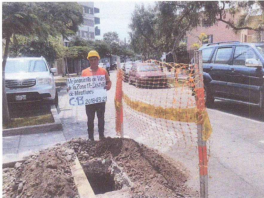
FOTOGRAFÍA N° 37: Ubicación de la calicata C-13 hacia el noreste del área de estudio, en la calle La Jara, cerca de su intersección con la calle Ortiz de Zevallos.
