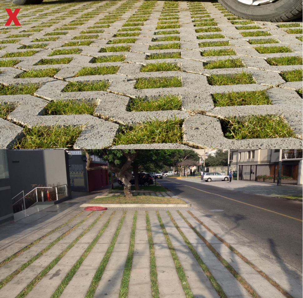
Figura 20. Imagen arriba: grass-block. Imagen abajo: franjas de concreto para estacionamientos
