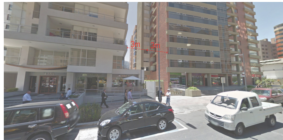
Figura 31. Aplicación de reiro de 3m a partir del segundo piso (Quito).
