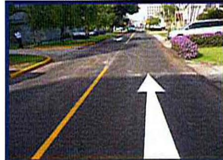
Los trabajos realizados en la calle Ignacio Merino Cdra. 6 son: 500 m2., de corte, demolición y eliminación de pavimento rígido; 500 m2. de sub base y base compactada, 500 m2 de imprimación y parchado con asfalto, 800 m2 de riego de liga asfáltica, 800m2., de carpeta nivelante total de 2" de asfalto en caliente y señalización horizontal de la vía.
